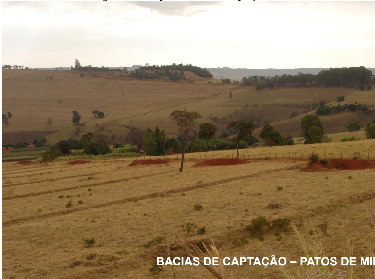
Figura 6: Exemplo de Bacia de Captação (2)
